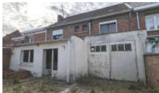
façade de l'existant
