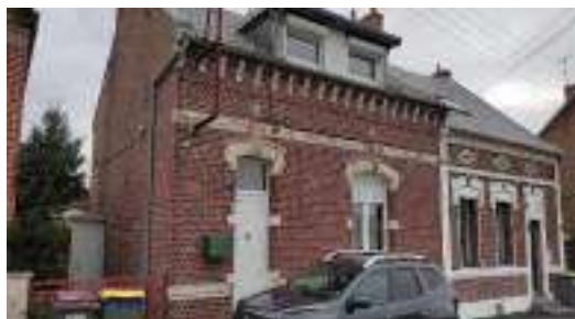
Devant le bâti (entrée porte blanche)
