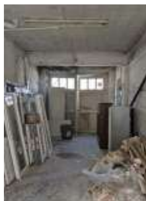
Garage traversant depuis la rue
