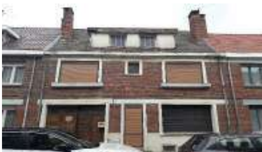
Façade de l'existant sur rue
