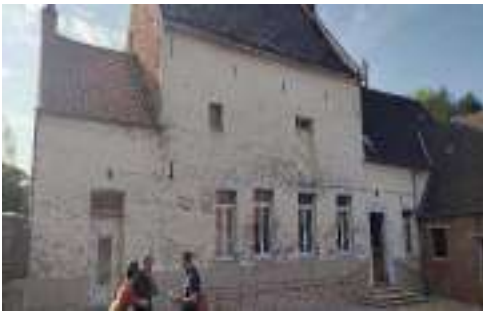
Façade de l'existant sur cour
