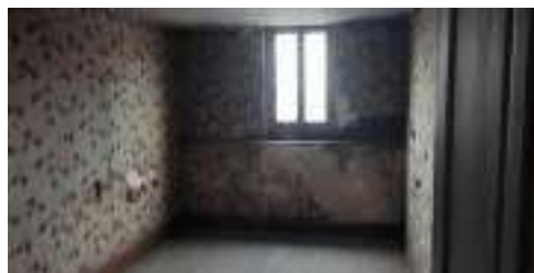
Une partie commune pour les 2 logements avec création de 2 cuisines
